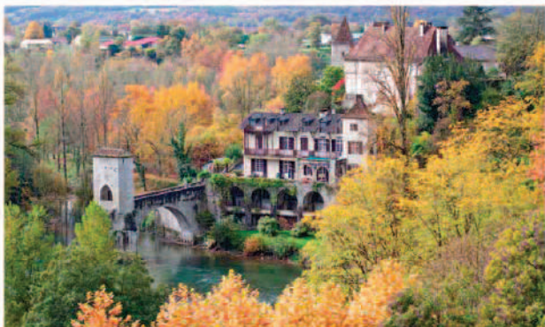
Pont de la Légende, the medieval bridge in Sauveterre-de-Béarn
