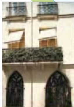
Windows of the Hôtel Rolland
