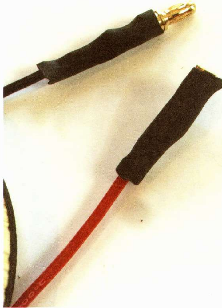
الشكل 10-10 ضع أنبوباً على الطرف واجعله ينكمش بالحرارة!
